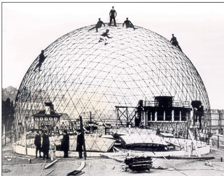
3. ábra: A jénai kupola szerkezetépítés közben
